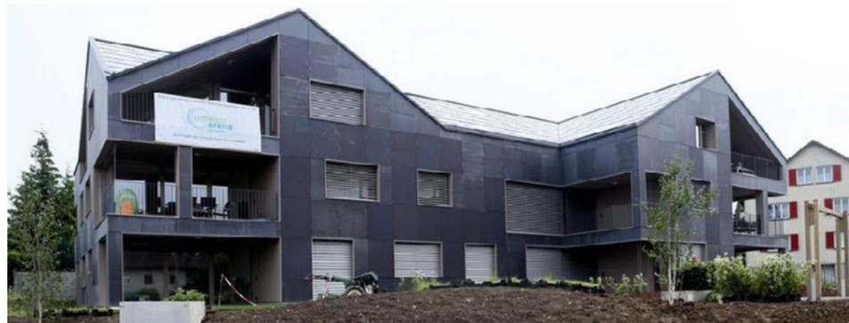
Ein Projekt, das Mut macht: Das erste energieautarke Mehrfamilienhaus der Welt steht in Brütten in der Nähe von Winterthur. Das Haus kommt ohne externen Anschluss für Strom, Öl und Erdgas aus. Die gesamte Energie wird von der Sonne bezogen und dank unterschiedlicher Speicherformen über das gesamte Jahr beziehbar gemacht.*bild: keystone*
